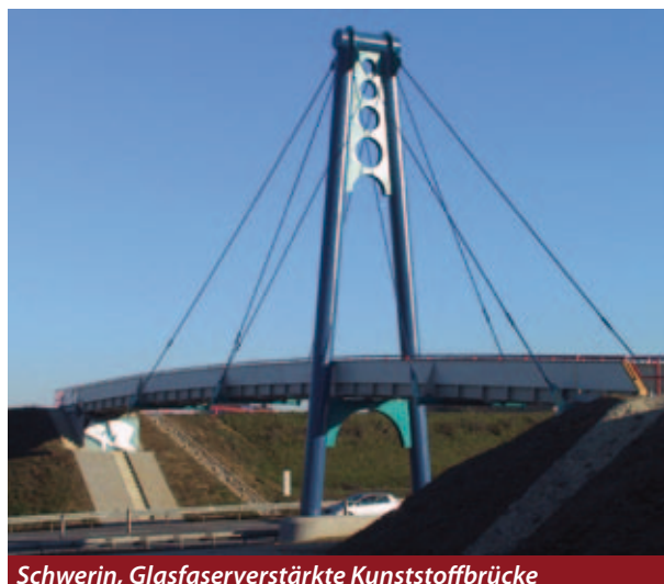
Schwerin, Glasfaserverstärkte Kunststoffbrücke
