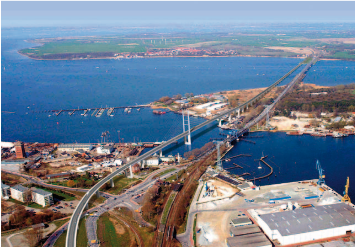
Rügen/ Stralsund, Rügenbrücke
