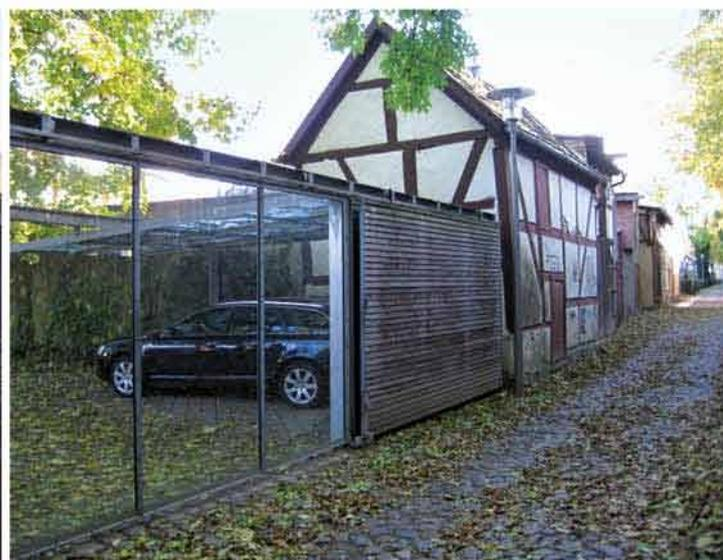
Die Toranlage geht mit dem feststehenden Teil als horizontale lamellenartige Strukturwand aus Lärche und vertikaler Teilung aus verzinktem Stahl und Glas sowie der transparenten Überdachung eine interessante Symbiose mit der mittelalterlichen Wallanlage ein.
