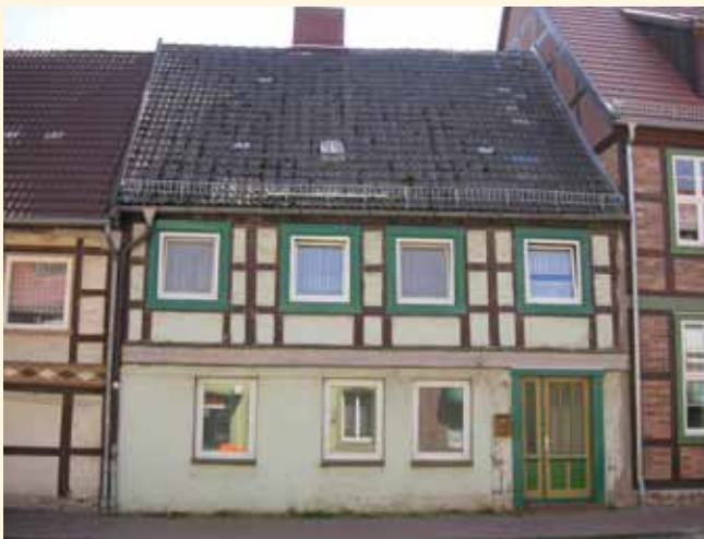
Höchste Eisenbahn: So heruntergekommen wie dieses Haus in der Luckower Straße sahen fast alle alten Fachwerkhäuser rund ums Rathaus aus, bevor die Sternberg Immobilien Verwaltungsgesellschaft sie sanierten.
