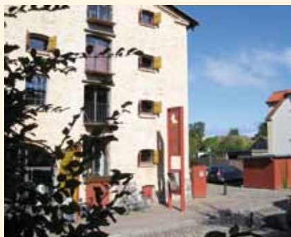
Aus dem alten Getreidespeicher wurde ein Schmuckstück, in dem Gäste gern gesehen sind.
