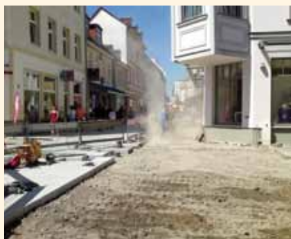
Acht Wochen früher als geplant wurde die Greifswalder Einkaufsstraße Schuhhagen saniert. Das Erfolgsrezept war der sorgfältige Umgang aller Beteiligten miteinander.
