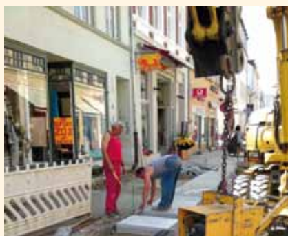
Anette Schulz schwärmt bis heute von den Bauarbeiten im Schuhhagen. „Von wegen mufflige Bauarbeiter“, stellt sie fest. Die seien so nett gewesen, dass sie die Männer kurzerhand zum Frühstück eingeladen habe.
