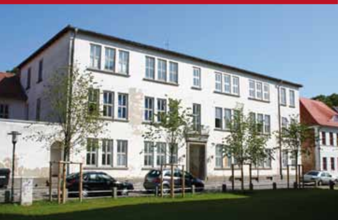
Vom Keller bis zum Dach – Altes herzogliches Amtsgericht wird zu neuem Verwaltungssitz umgebaut
