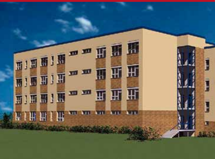
Farbtupfer für die Kleinen – Grundschule im Rostocker Stadtteil Toitenwinkel wird saniert
