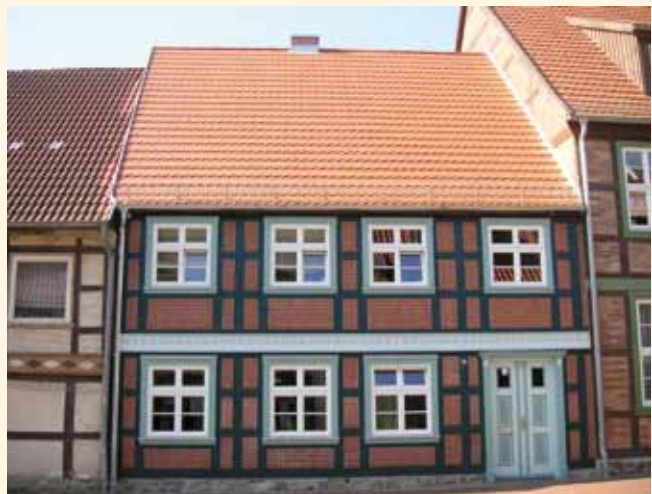
Nach der Sanierung erstrahlt dieses alte Fachwerkhäuser in der Luckower Straße wieder im neuen Glanz.
